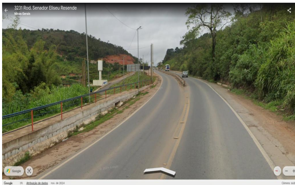
Figura 3 - Início/término do tramo da defesa metálica e terminal absorvedor de energia
