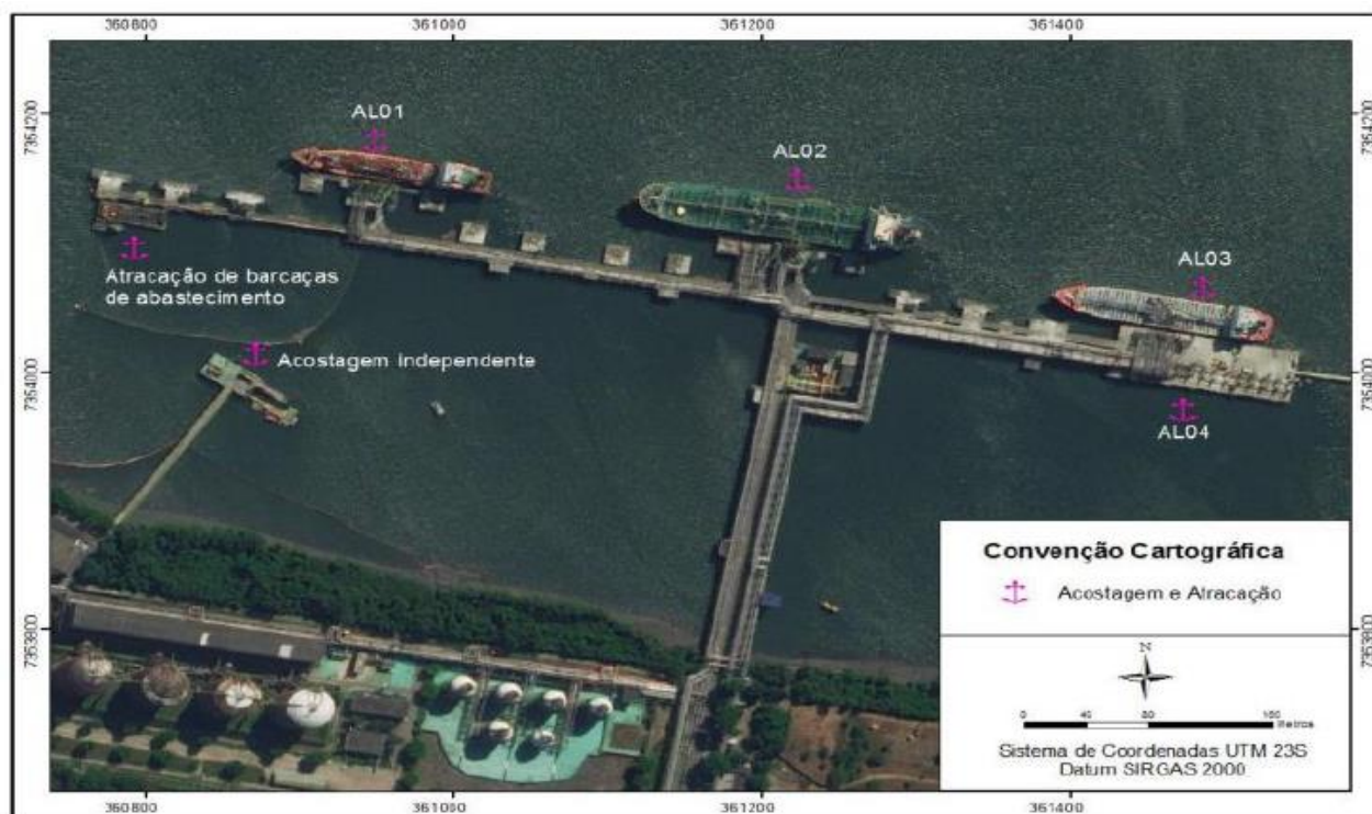
Figura 3 – Infraestrutura de acostagem dos terminais de granéis líquidos da Alemoa
