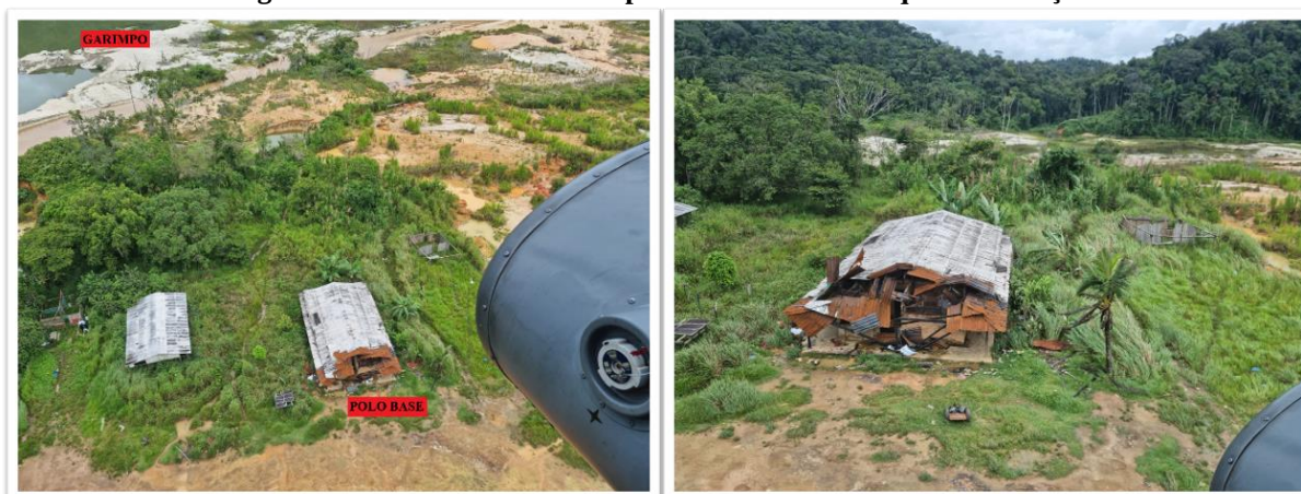
Figura 29 - Polo Base Homoxi após o incidente de ataque à edificação
