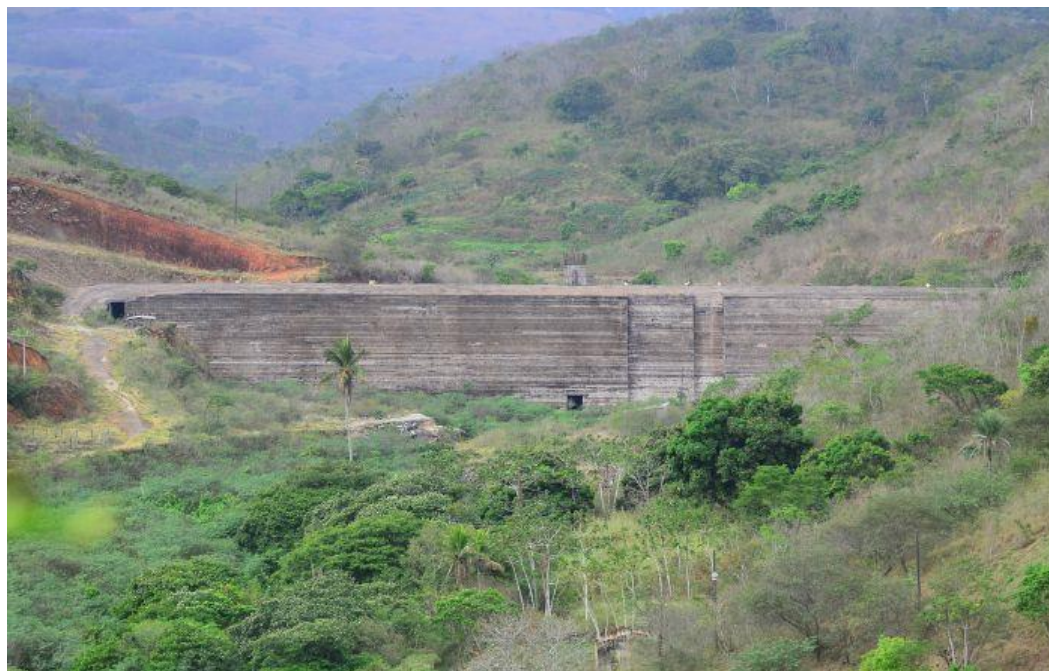
Figura 1: Foto da Barragem Panelas II, construída parcialmente em CCR (vertedouro em soleira livre incorporado ao corpo da barragem).
