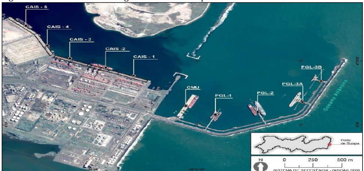
Figura 2: Infraestrutura de acostagem do Porto de Suape/PE
