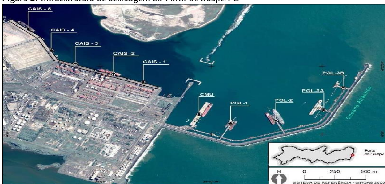
Figura 2: Infraestrutura de acostagem do Porto de Suape/PE
