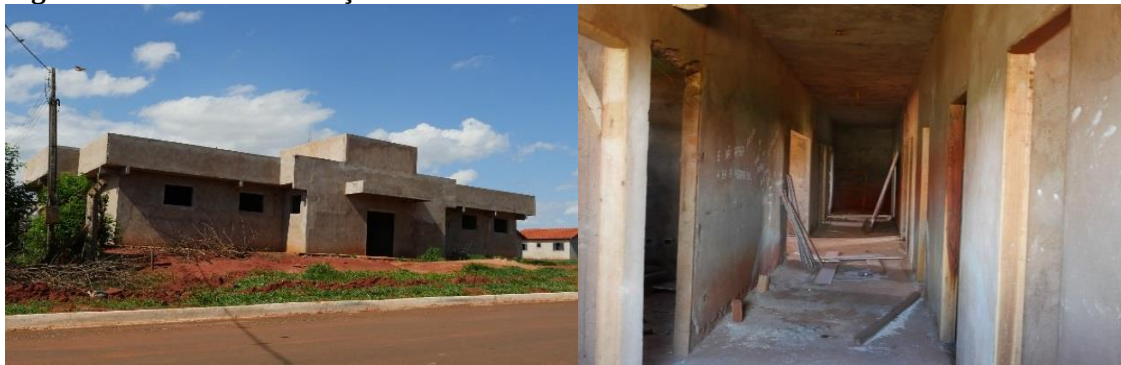
Figura 9 - Obra de construção UBS Bairro Vila Nova
