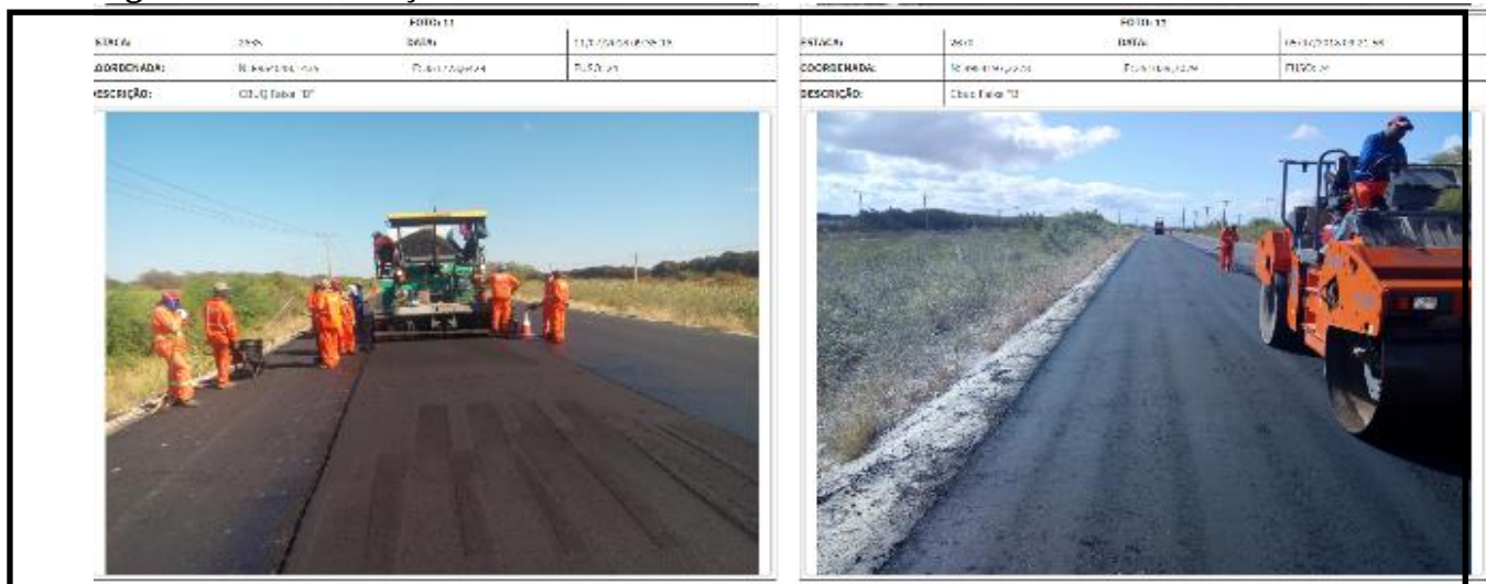
Figura 5: Pavimentação - est. 2625 e 2835
