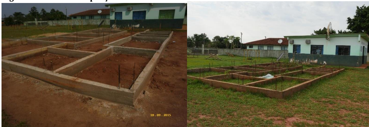
Figura 11 - Obra de ampliação UBS Jatobá
