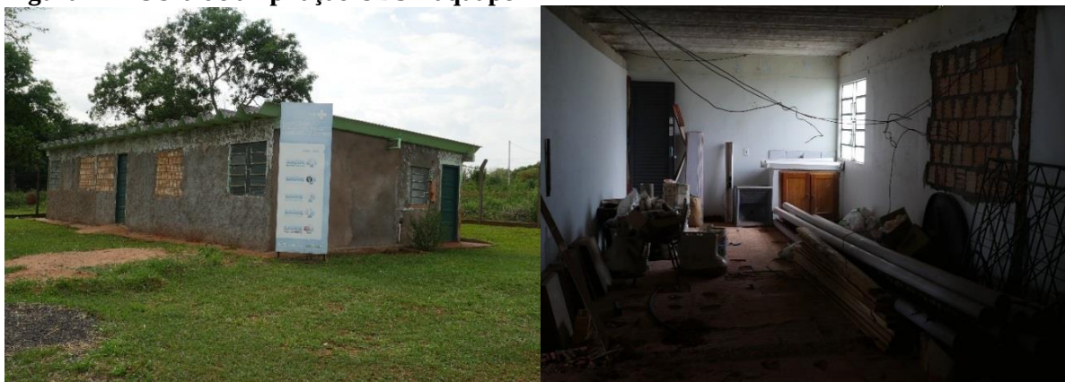
Figura 12 - Obra de ampliação UBS Taquaperi
