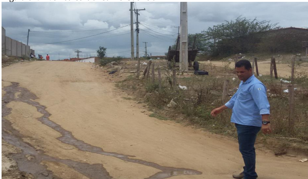
Figura 08: Rua pendente de execução
