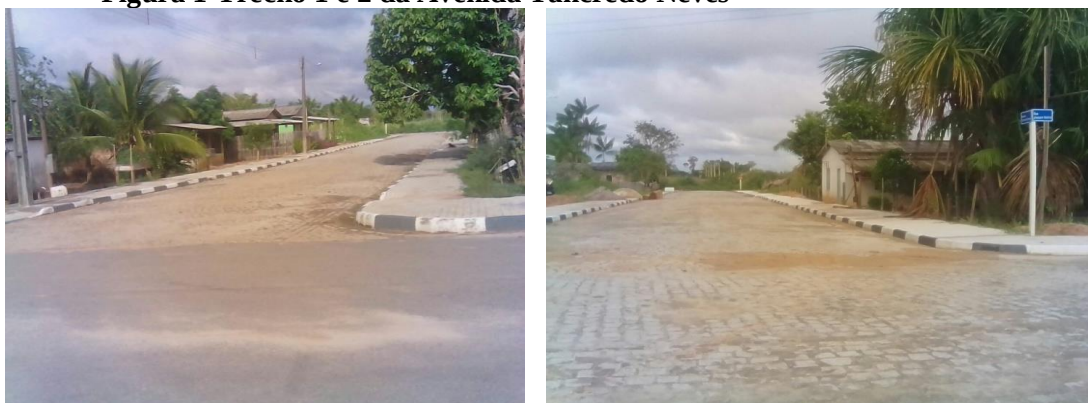
Figura 1-Trecho 1 e 2 da Avenida Tancredo Neves
