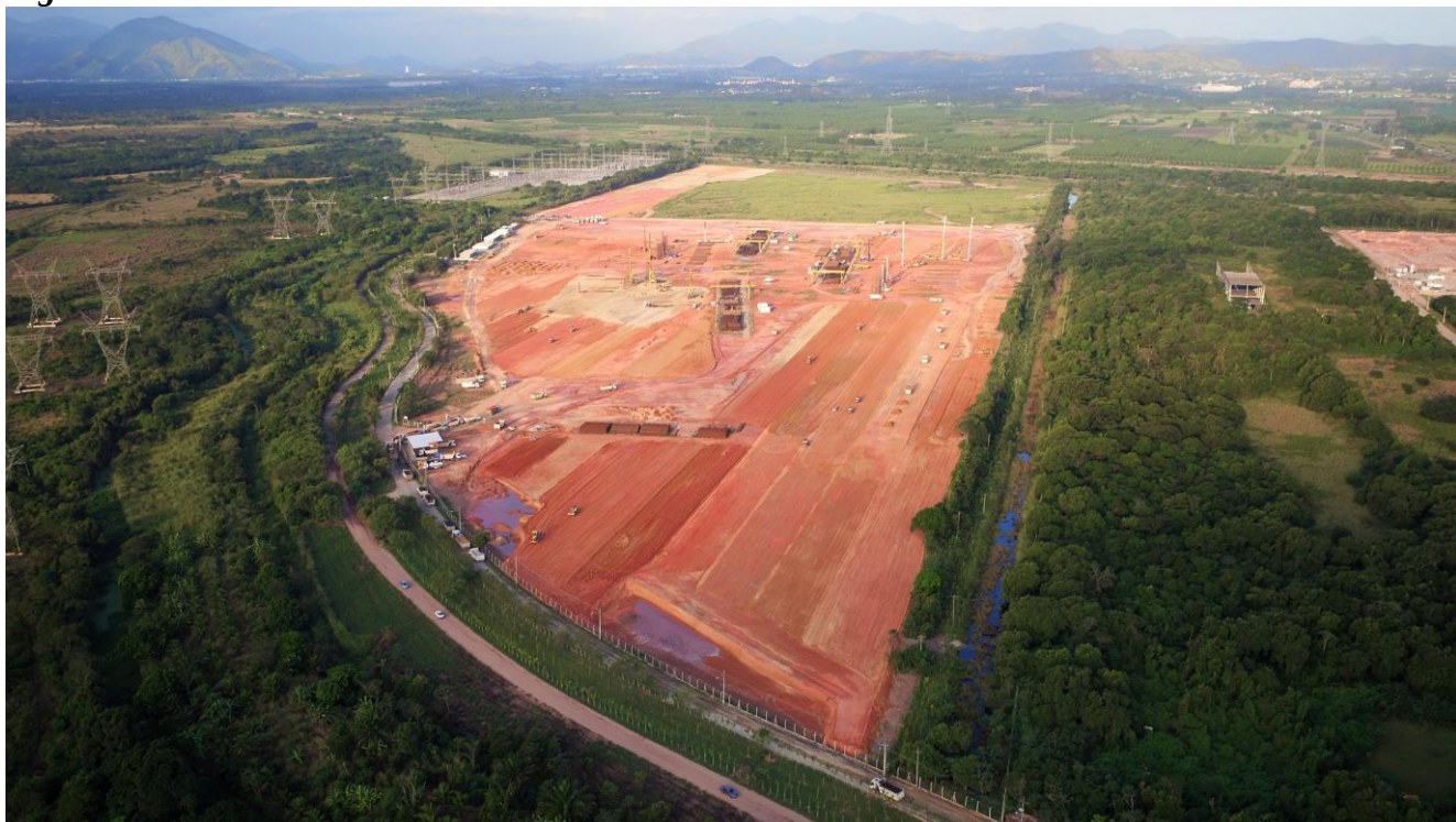
Figura 2 – Obras do NCPFI em maio de 2016
